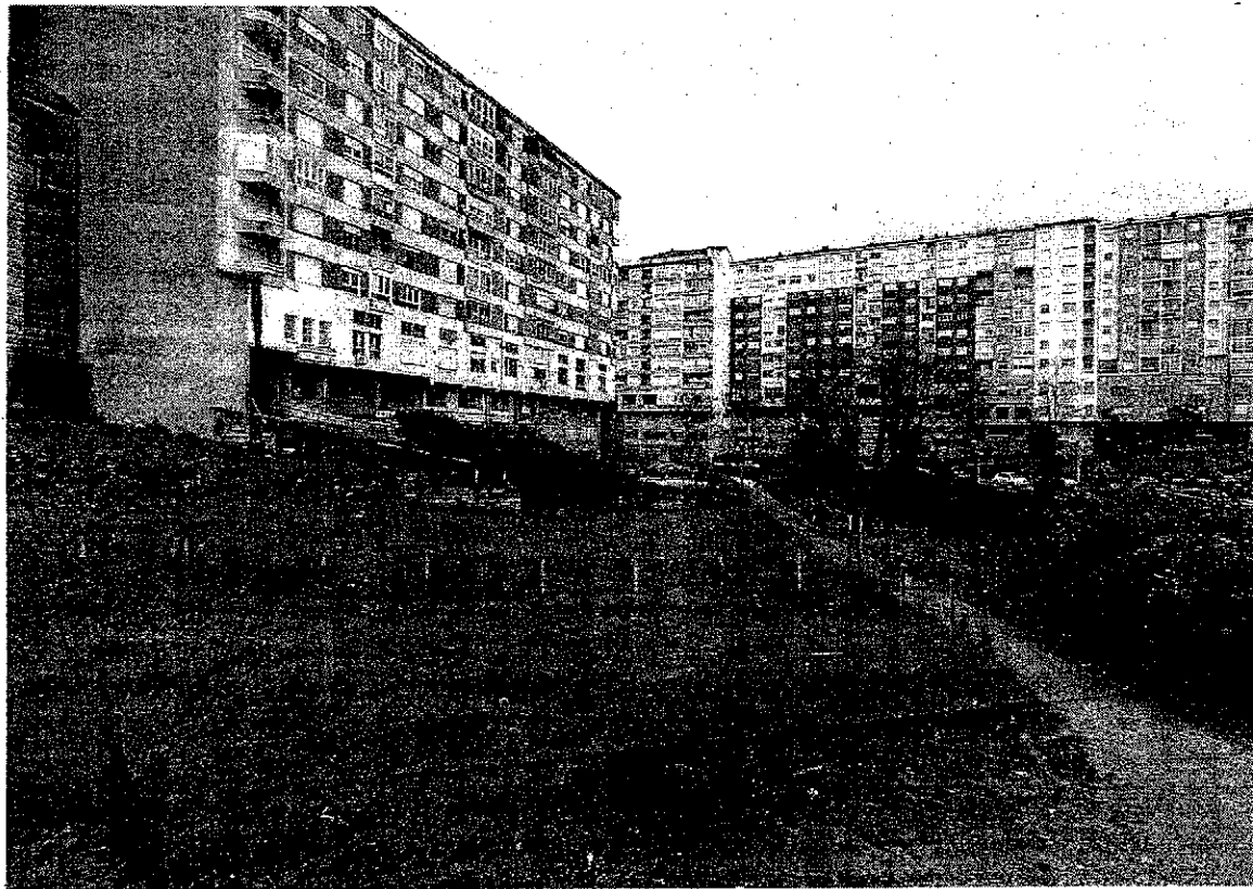
Imagen de la parcela, ahora interior, que habría que reparcelar, lo que obliga a demoler los edificios.
