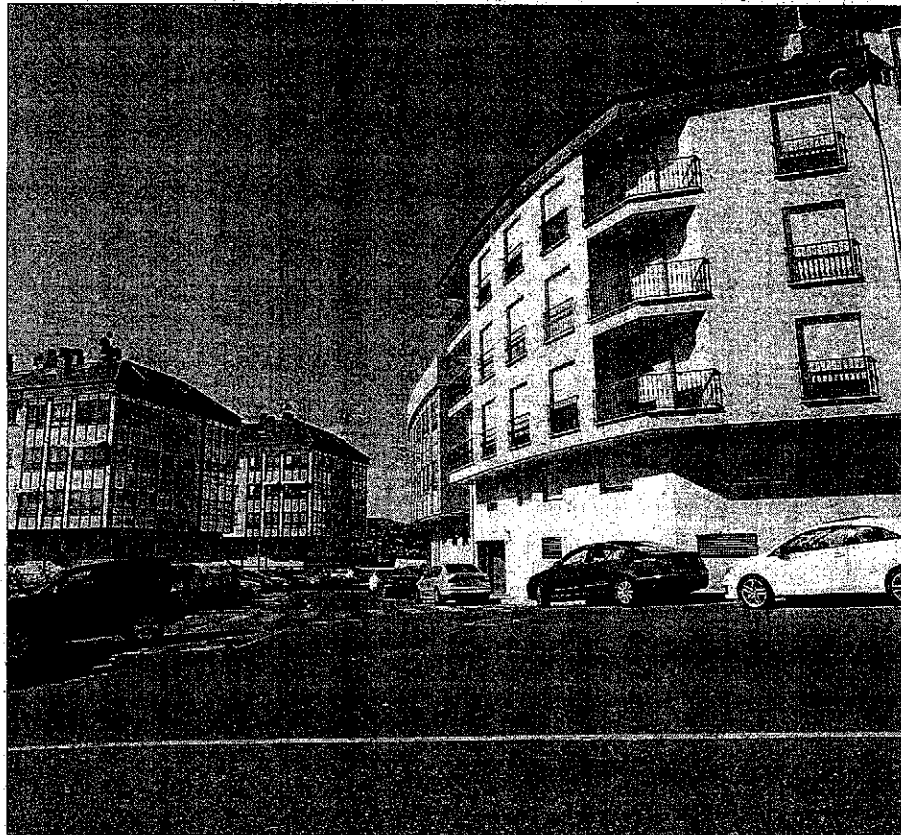
A la derecha, en curva, el edificio denunciado y con sentencia de derribo. // Jesús Regal
